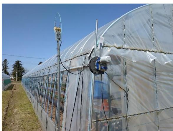
導入した側窓自動換気装置
