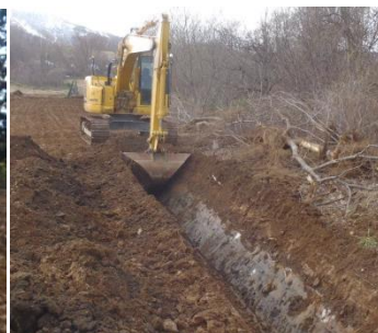
バックホーによる土水路掘削
