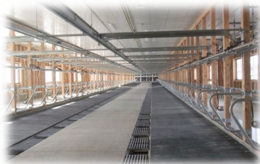
畜舎内部(洋野町)
