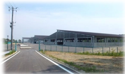
堆肥処理施設外観(洋野町)
