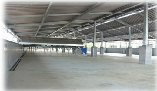
堆肥処理施設内部(洋野町)
