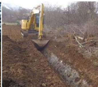
バックホーによる土水路掘削
