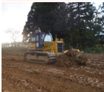
ブルドーザーによる簡易な起伏修正、表土扱い
