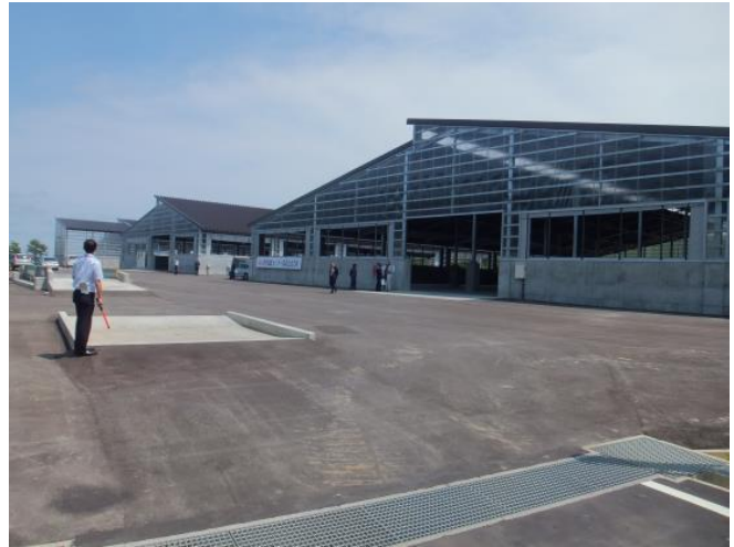
完成した「洋野堆肥センター」
